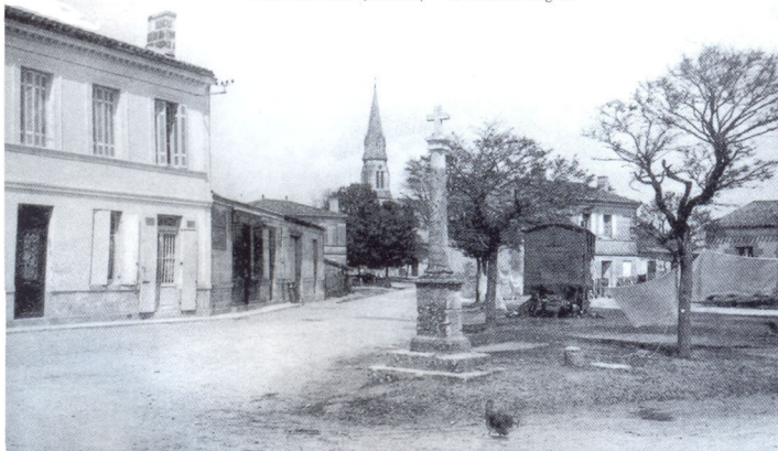
ARSAC, Médoc (Gironde) — Avenue de l'Église
