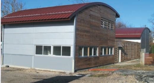
Les nouveaux garages et ateliers municipaux.
